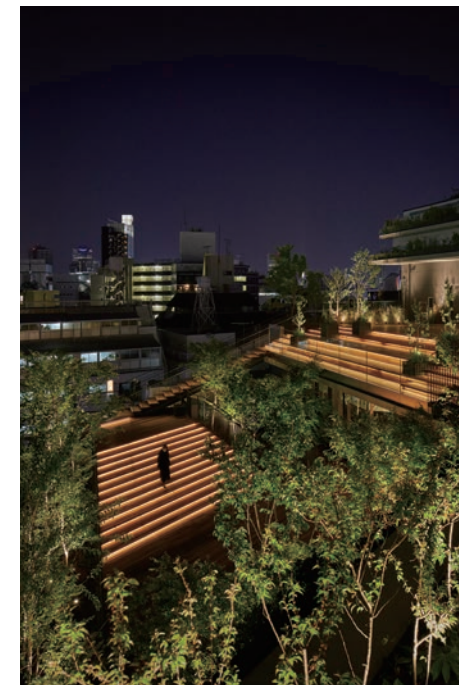
ウィズ原宿 設計：株式会社竹中工務店+伊東豊雄建築設計事務所 施工：株式会社竹中工務店 照明デザイン：有限会社シリウスライティングオフィス 撮影：鈴木文人
