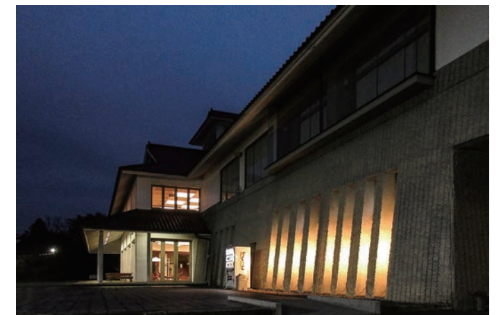
栃木県高根沢町 道の駅たかねざわ 元気あつむら 本館外壁掘込み照明
