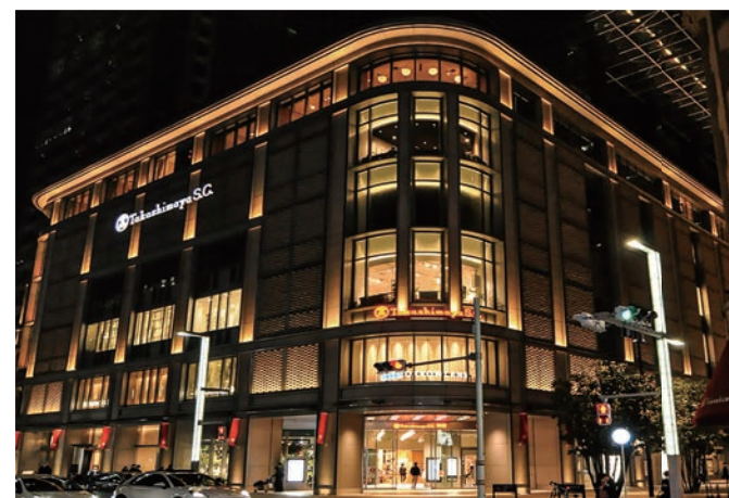
日本橋高島屋 新館 設計：株式会社日本設計 ライティングデザイン：内原智史デザイン事務所
