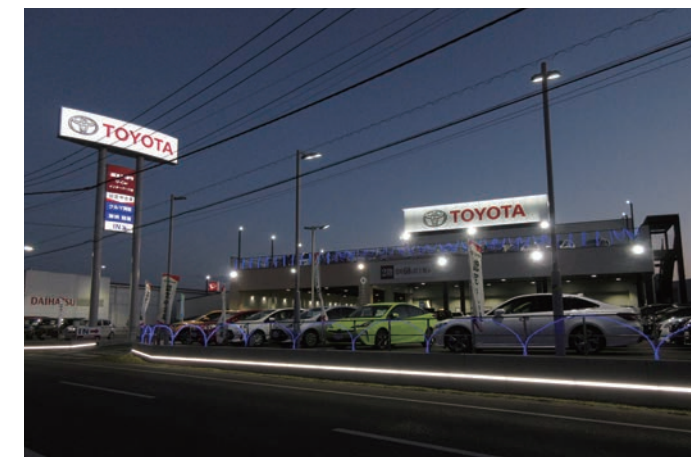
栃木トヨタ U-Carインターパーク店 施主：栃木トヨタ自動車株式会社 施工：株式会社関電電 照明協力：藤井産業株式会社
