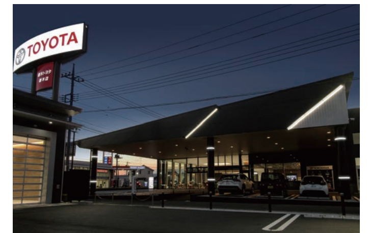
栃木トヨタ 栃木店 施工主：栃木トヨタ自動車株式会社 施工：株式会社関電電 照明協力：藤井産業株式会社
